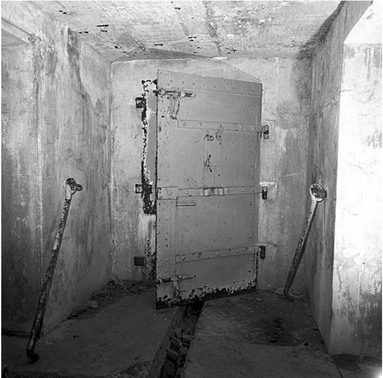
Vestibule d'entrée. Vue de la porte.
