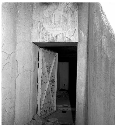
Quatrième entrée. Vue extérieure. Phot. Marc Heller, Phot. Gérard Roucaute IVR93_19910400678X
