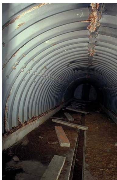
Vue intérieure d'un abri pris dans l'axe du local. Phot. Marc Heller, Phot. Gérard Roucaute IVR93_19910401051ZA
