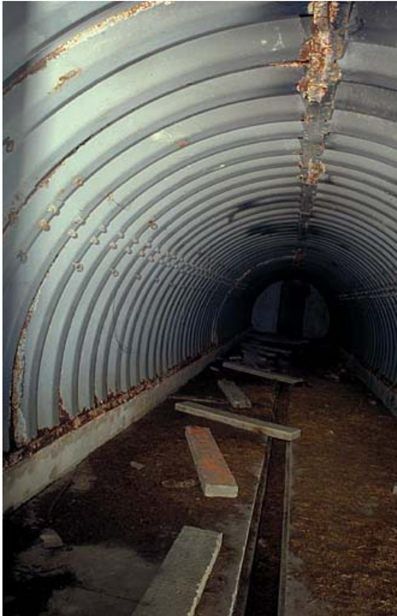
Vue intérieure d'un abri pris dans l'axe du local.
