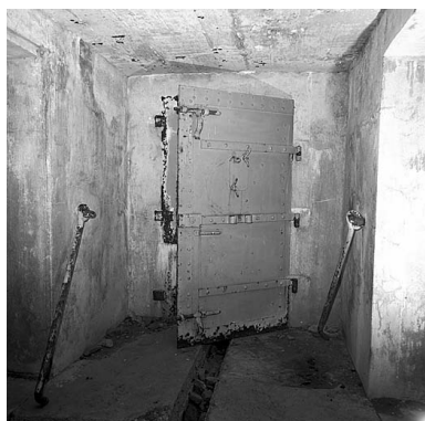
Vestibule d'entrée. Vue de la porte. Phot. Marc Heller, Phot. Gérard Roucaute IVR93_19910400674X
