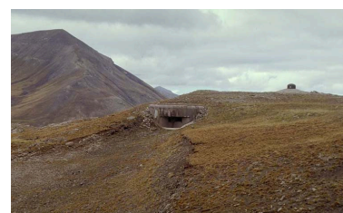
Vue partielle des dessus.
