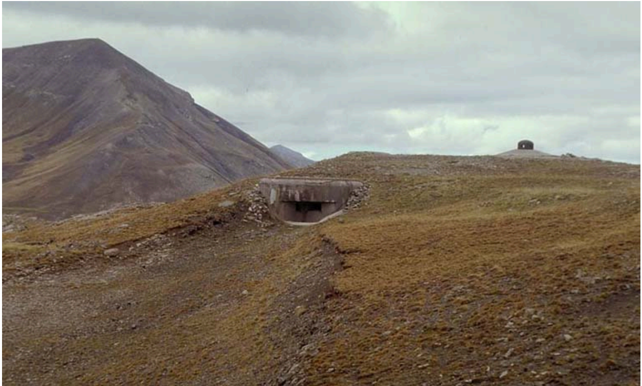
Vue partielle des dessus.
