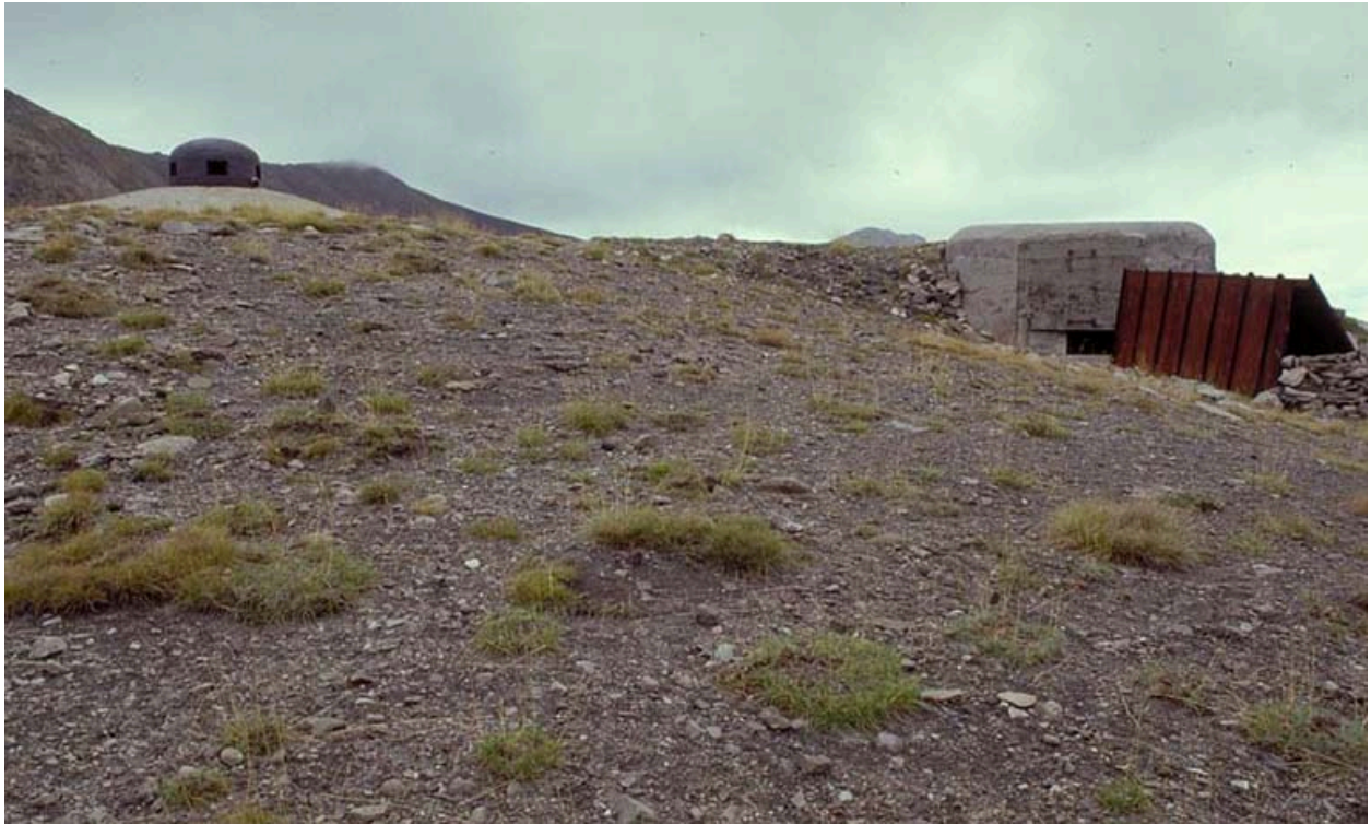
Vue partielle des dessus.
