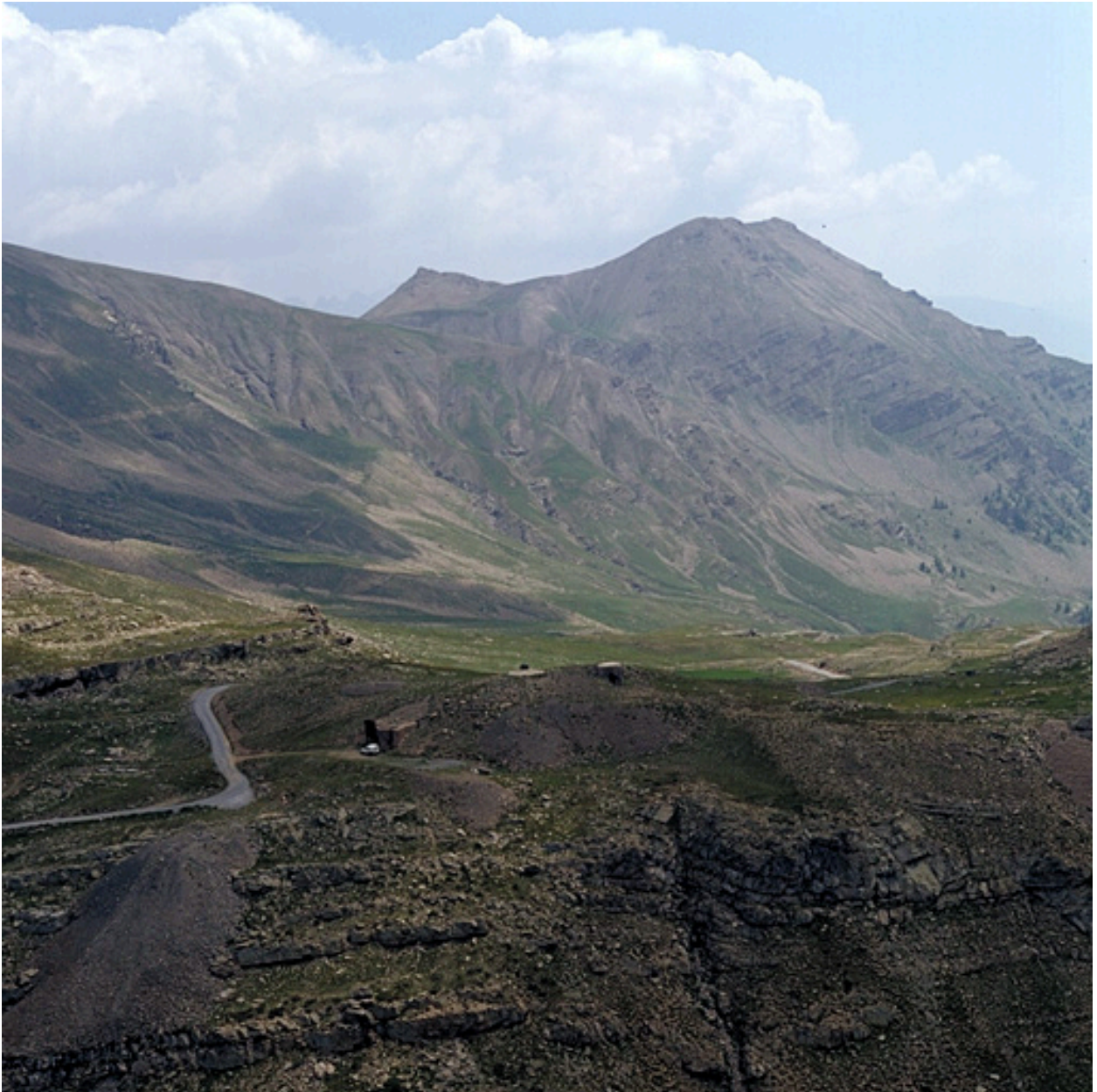
Ensemble vu du nord-ouest.
